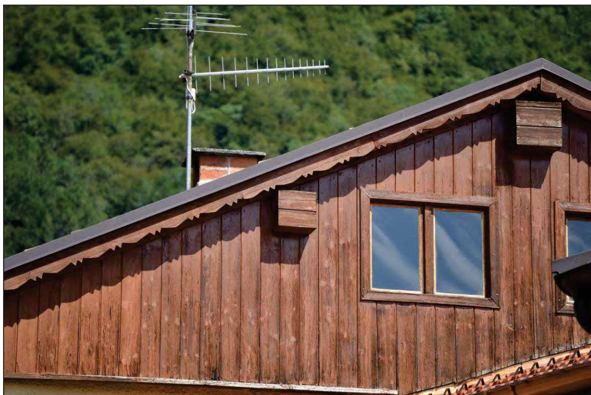
RIVESTIMENTI AL SOTTOTETTO
