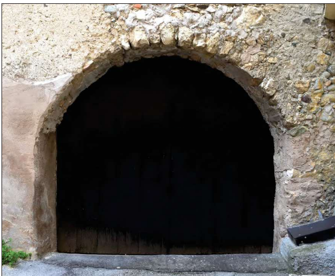
FORMA AD ARCO IN MURATURA
