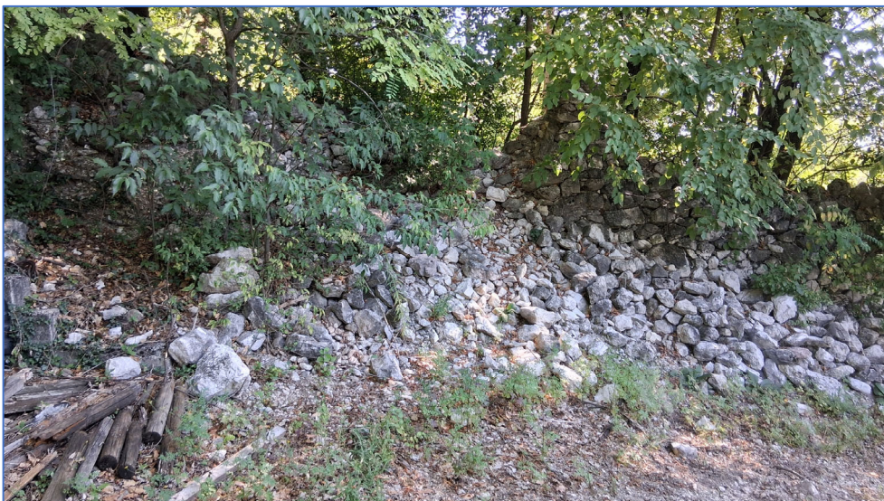
Foto 10.2 – pezzatura dei blocchi rilevati alla base del fronte roccioso, entro l’impluvio esistente (vecchio alveo della Val de la Vila)
