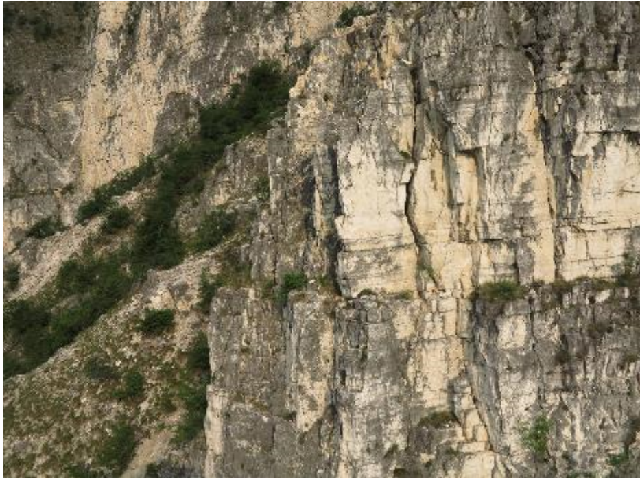
Figura 23 – porzione di ammasso molto degradato situato a Nord del conoide
