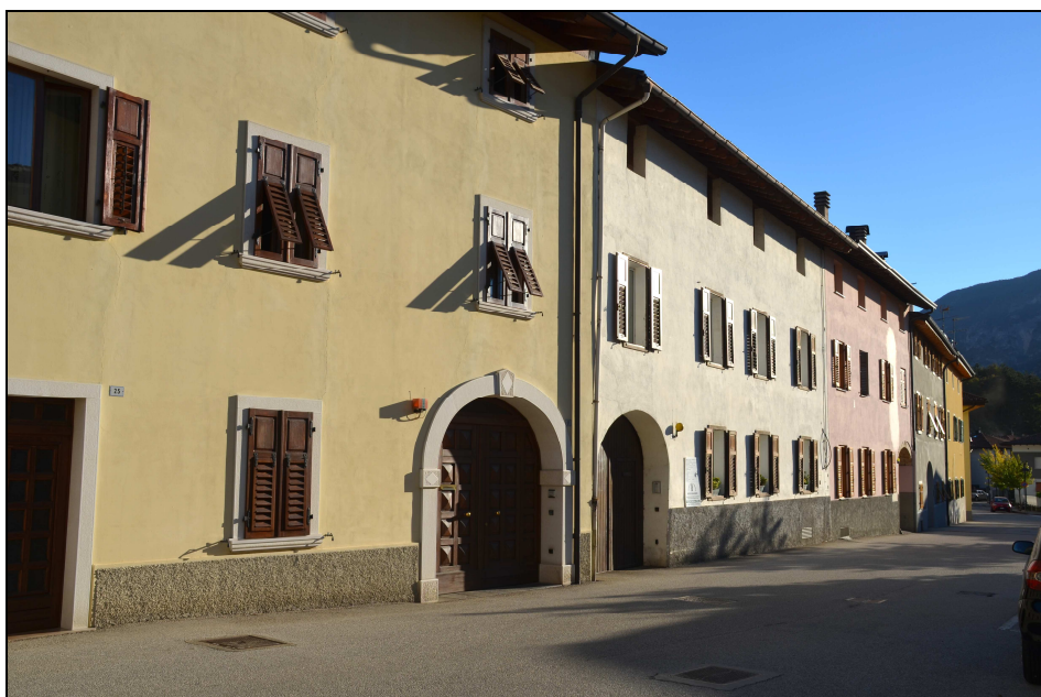
Esempi di fronti edilizi (facciate n. 56-57-58-59 in via Roma) rilevati in zona residenziale B1 di antica formazione
