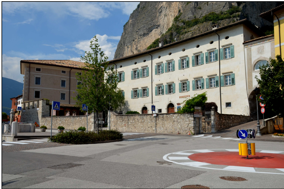
Esempi di fronti edilizi con vincolo di facciata (prospetti n. 7 e 13 del Piano colore) rilevati in centro storico
