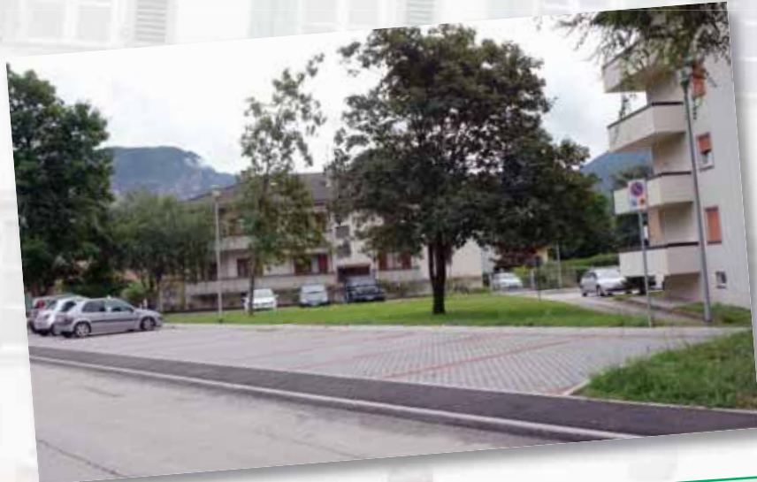
Nuovi parcheggi in via Fornai
