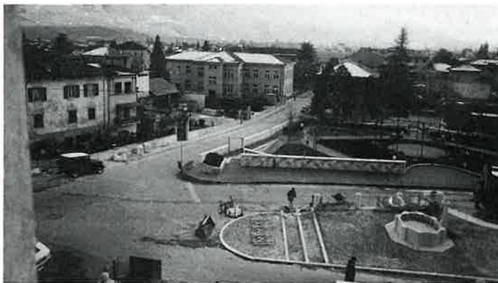
Uno scorcio dei lavori di Piazza Chiesa e via Dante
