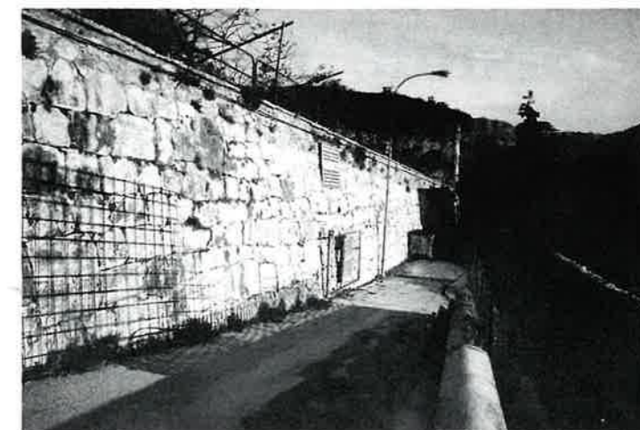
Il muro di via Baron Cristani dove verranno realizzati i parcheggi
