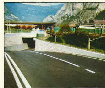
Il sottopasso di via Canè finalmente aperto dopo anni di lavori.
