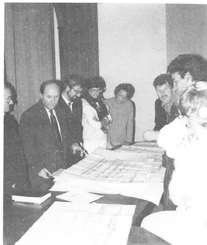
L'Architetto Pedri, durante un consiglio comunale appositamente convocato in via informale, ha illustrato il progetto relativo alla ristrutturazione del Cason, compiendo poi un sopralluogo nel cantiere assieme a tutti consiglieri comunali
