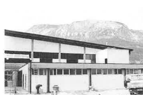
Completamento dei lavori all'esterno
