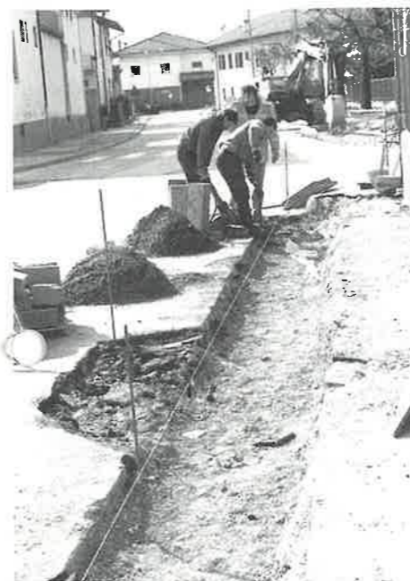
Costruzione del marciapiede in via Rotaliana
