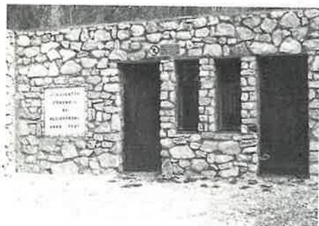
Il nuovo serbatoio dell'acquedotto
