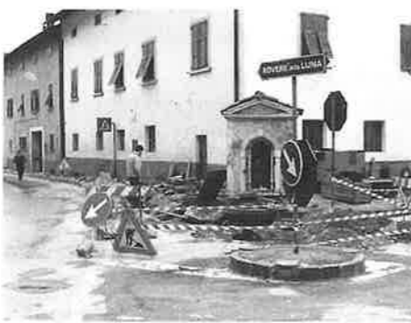
Rifacimento della "Rogiata" in via Borgo Nuovo
