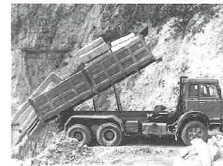
La discarica di inerti a Maso Nuovo
