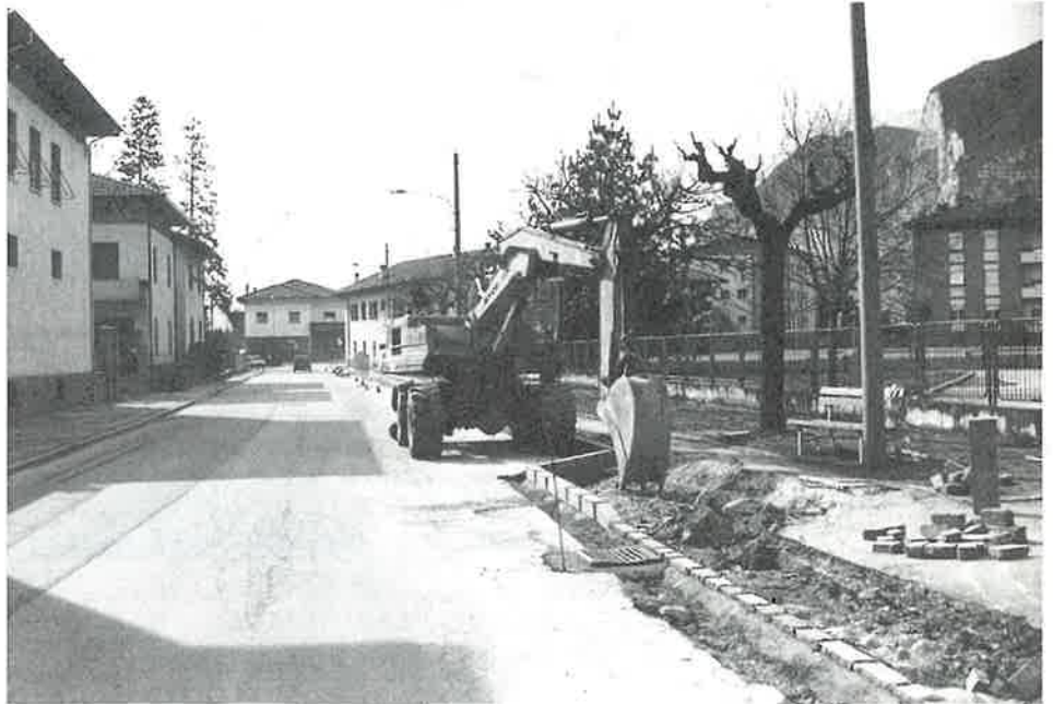
Costruzione del marciapiede in via Rotaliana
