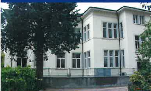
2. Sistemazione esterna edificio Scuola elementare
