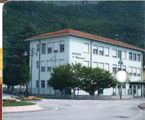
3. Sistemazione esterna edificio Scuola elementare
