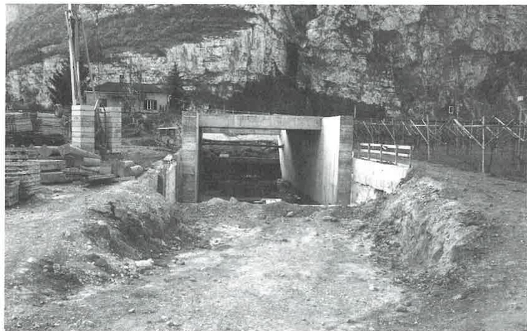
Il sottopasso ferroviario "Primo casello"
