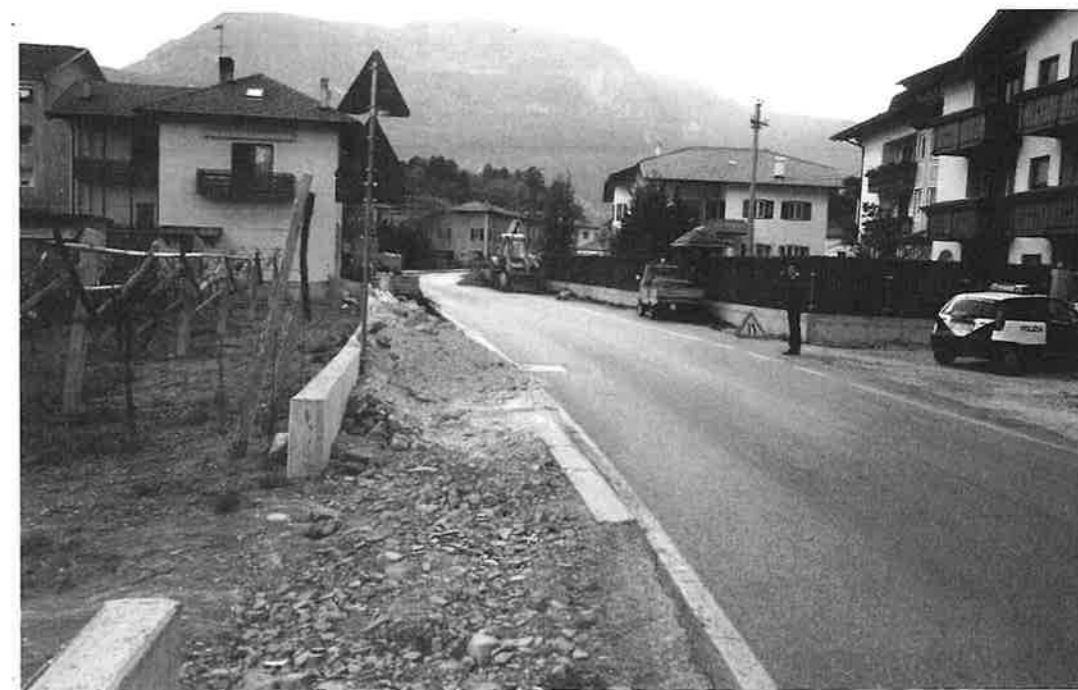
I marciapiedi in costruzione di via Borgonuovo
