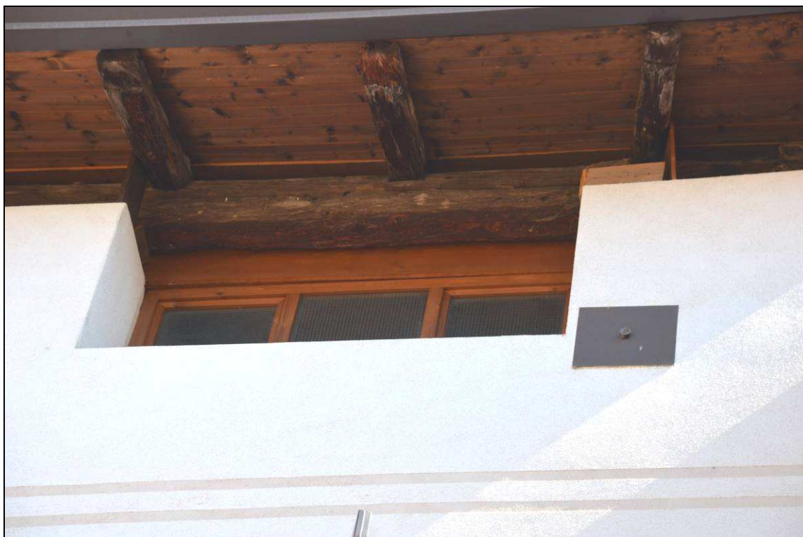
TRAVI DI BANCHINA
