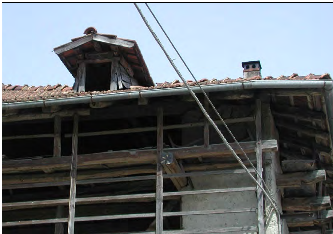
POGGIOLI E BALLATOI CON PARAPETTI IN LEGNO A FILETTI ORIZZONTALI
