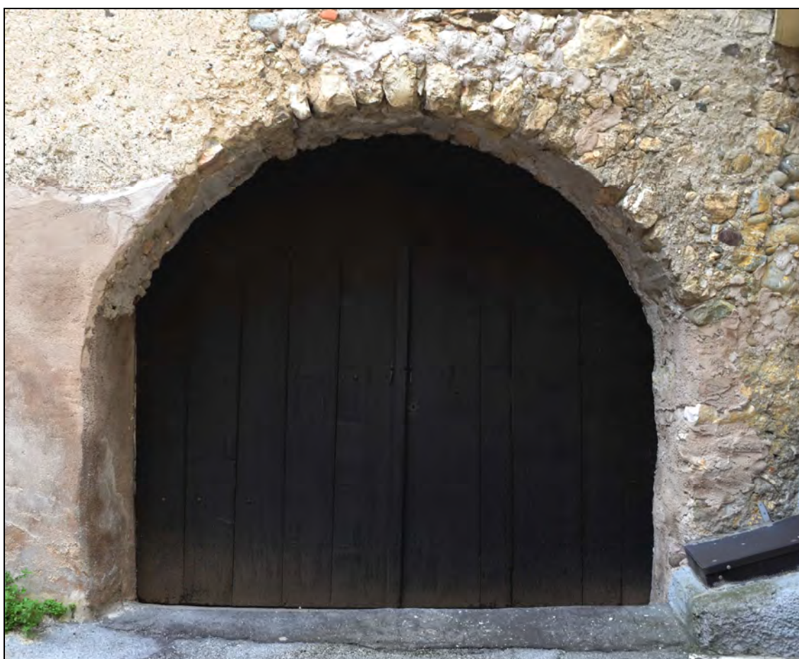
FORMA AD ARCO IN MURATURA
