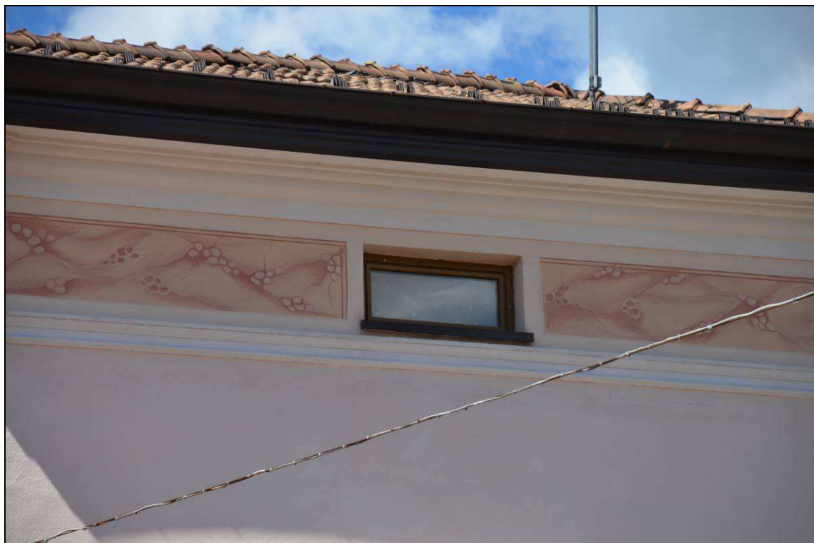
FORI RETTANGOLARI NEL SOTTOTETTO
