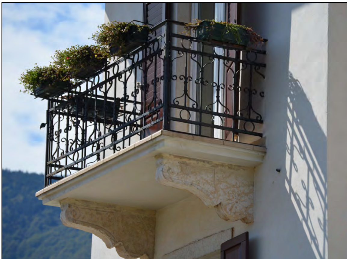
BALCONI CON RINHIERA IN FERRO LAVORATO
