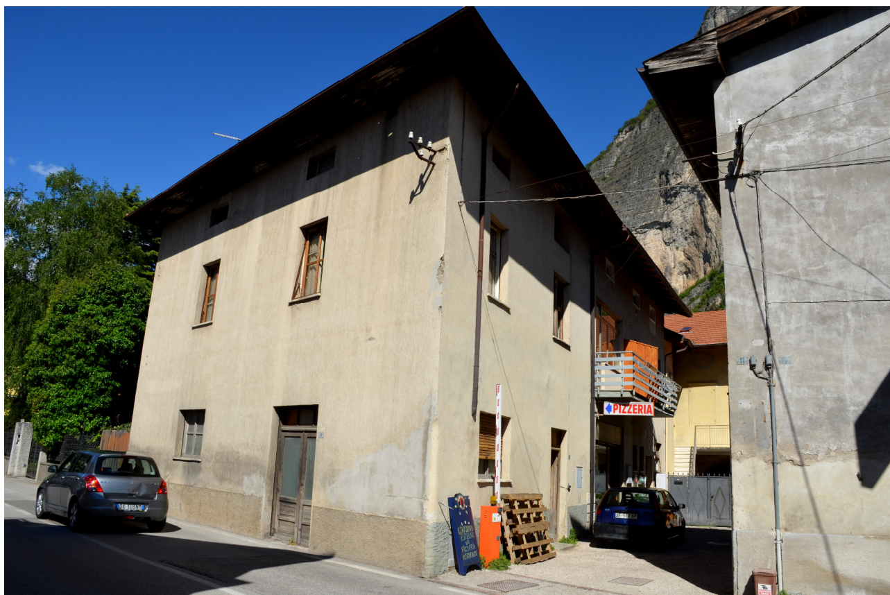
SCORCIO SUD EST U.E. 309
