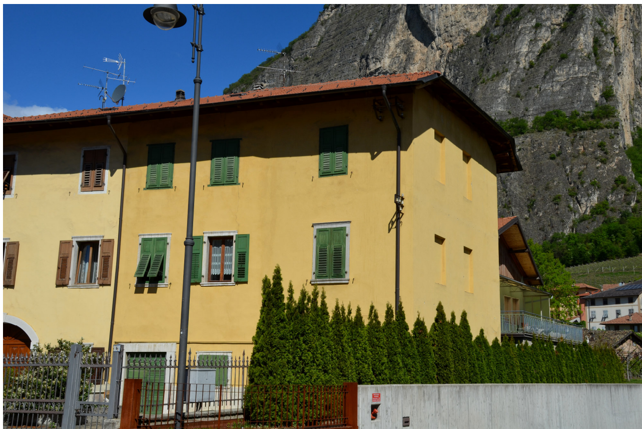
SCORCIO SUD EST U.E. 315
