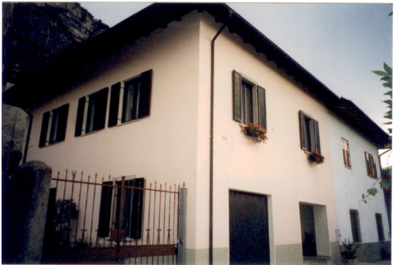
SCORCIO SUD DOPO LA RISTRUTTURAZIONE
