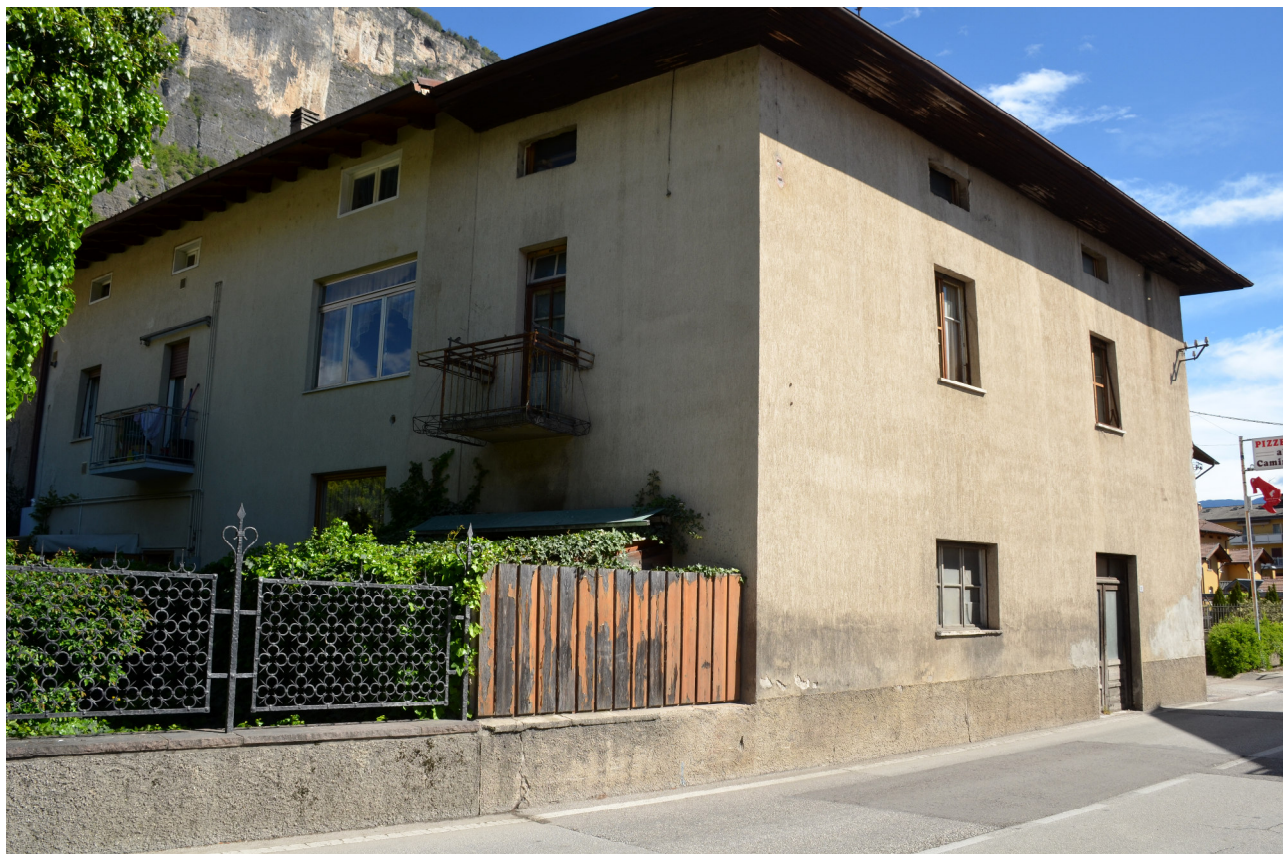
SCORCIO SUD OVEST U.E. 309
