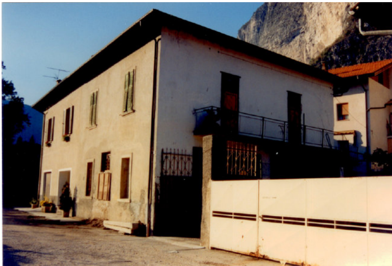
SCORCIO SUD EST PRIMA DELLA RISTRUTTURAZIONE
