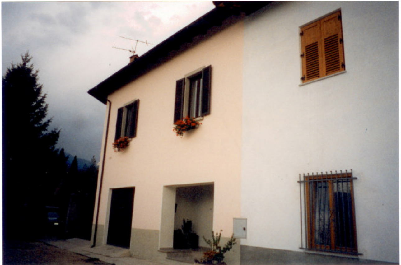
SCORCIO SUD DOPO LA RISTRUTTURAZIONE
