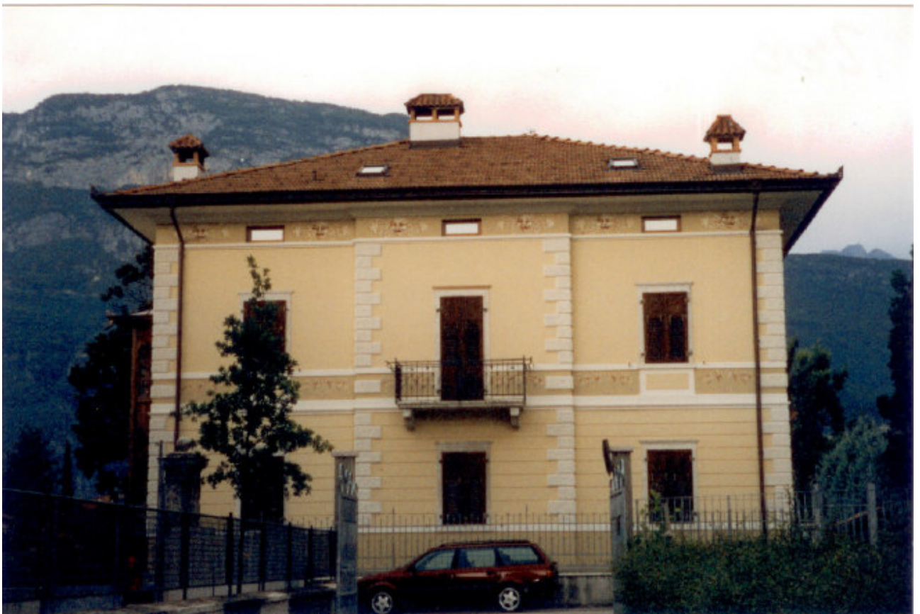
FRONTE EST (dopo il risanamento)
