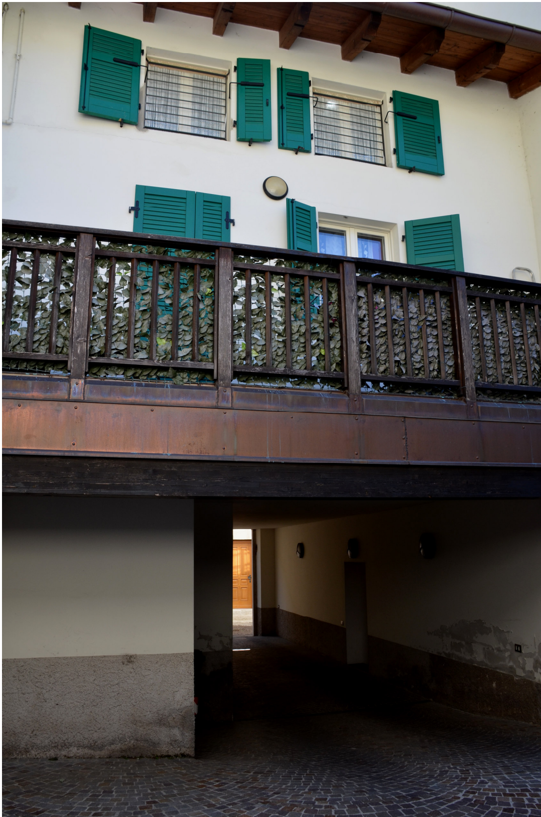
SCORCIO NORD (interno cortiletto)
