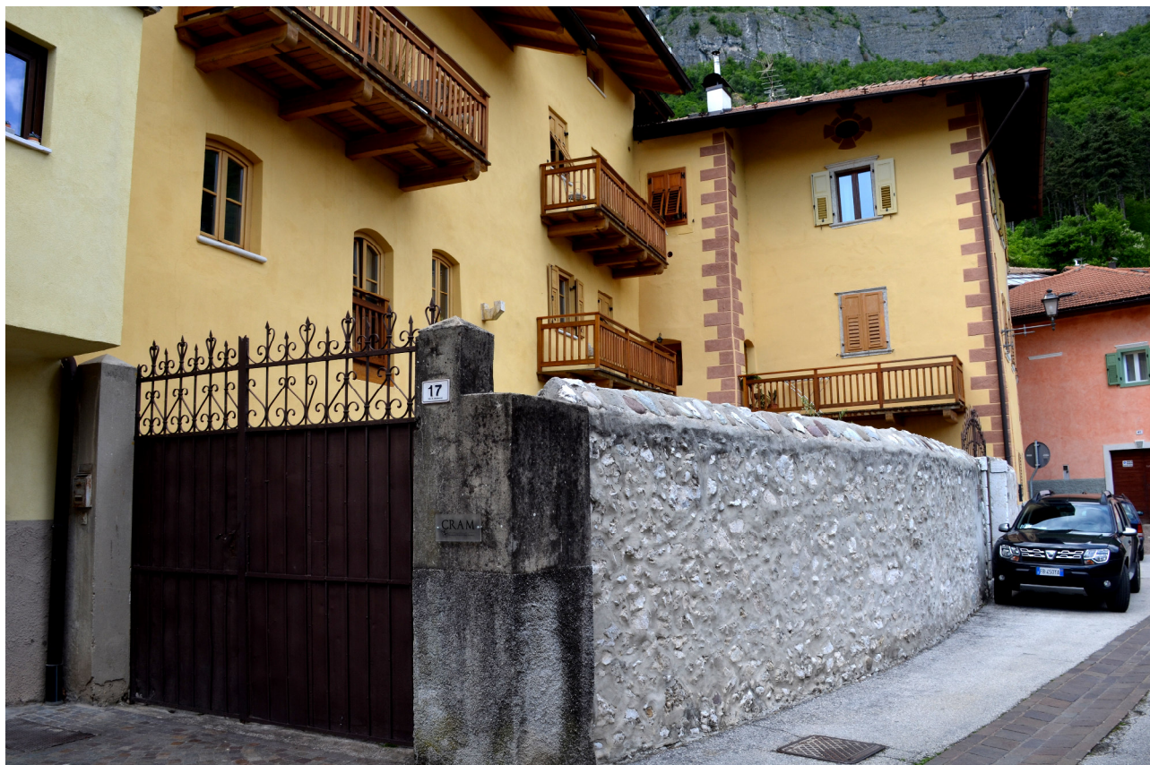
SCORCIO OVEST (esterno)
