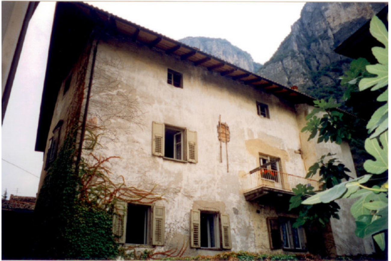
SCORCIO FRONTE EST
