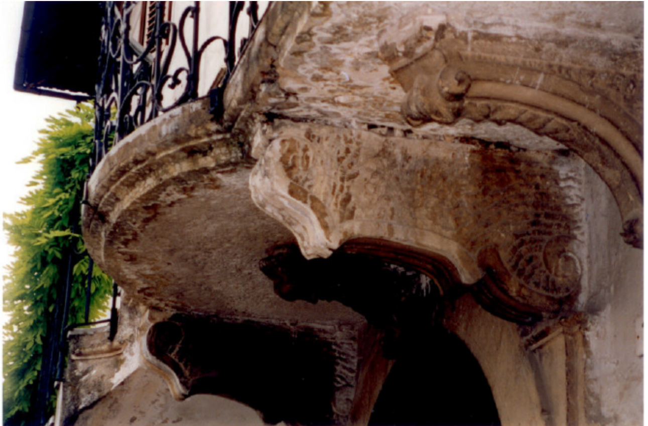
PARTICOLARE SUL FRONTE SUD
