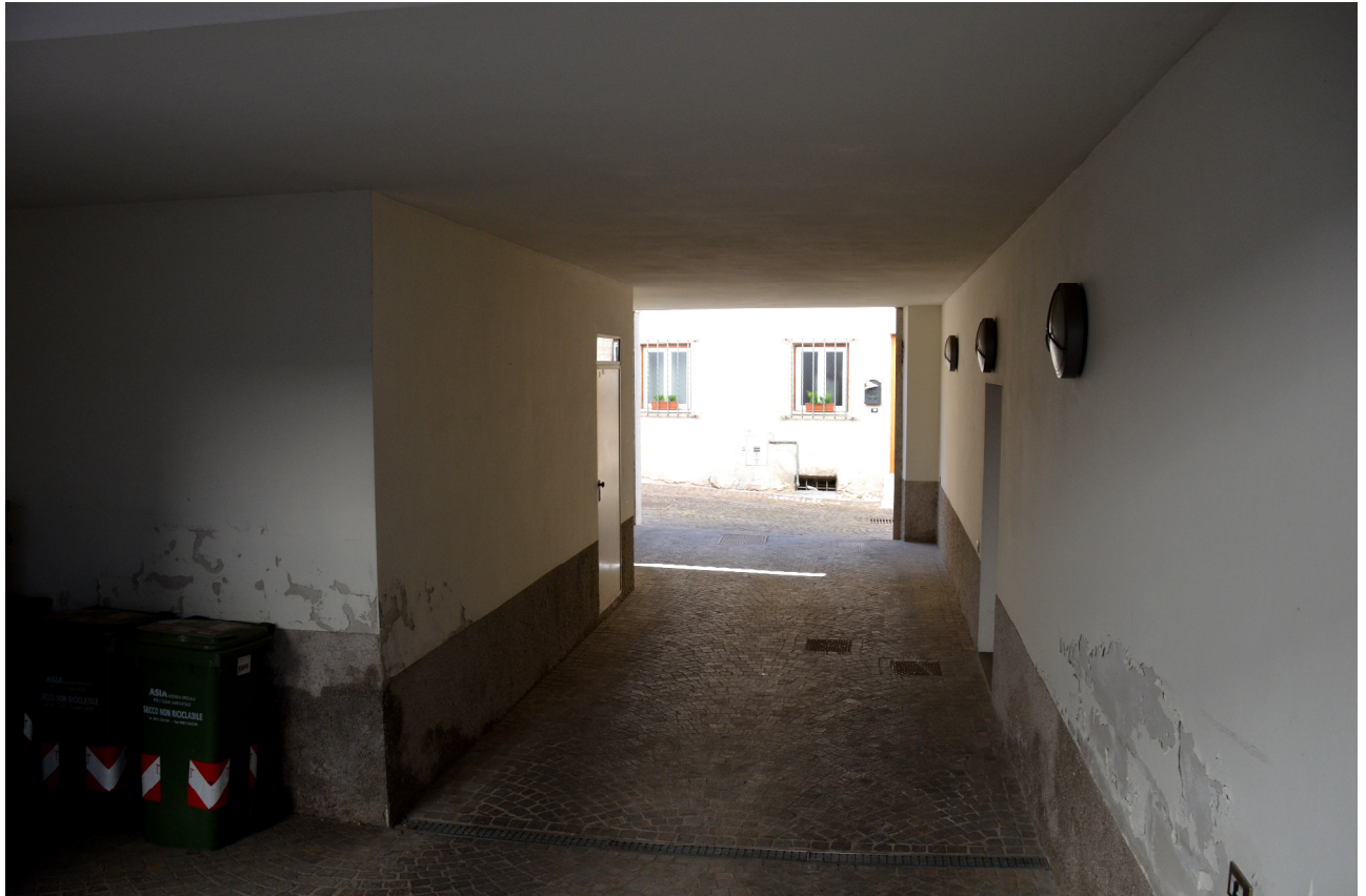
SCORCIO NORD (portico passante)
