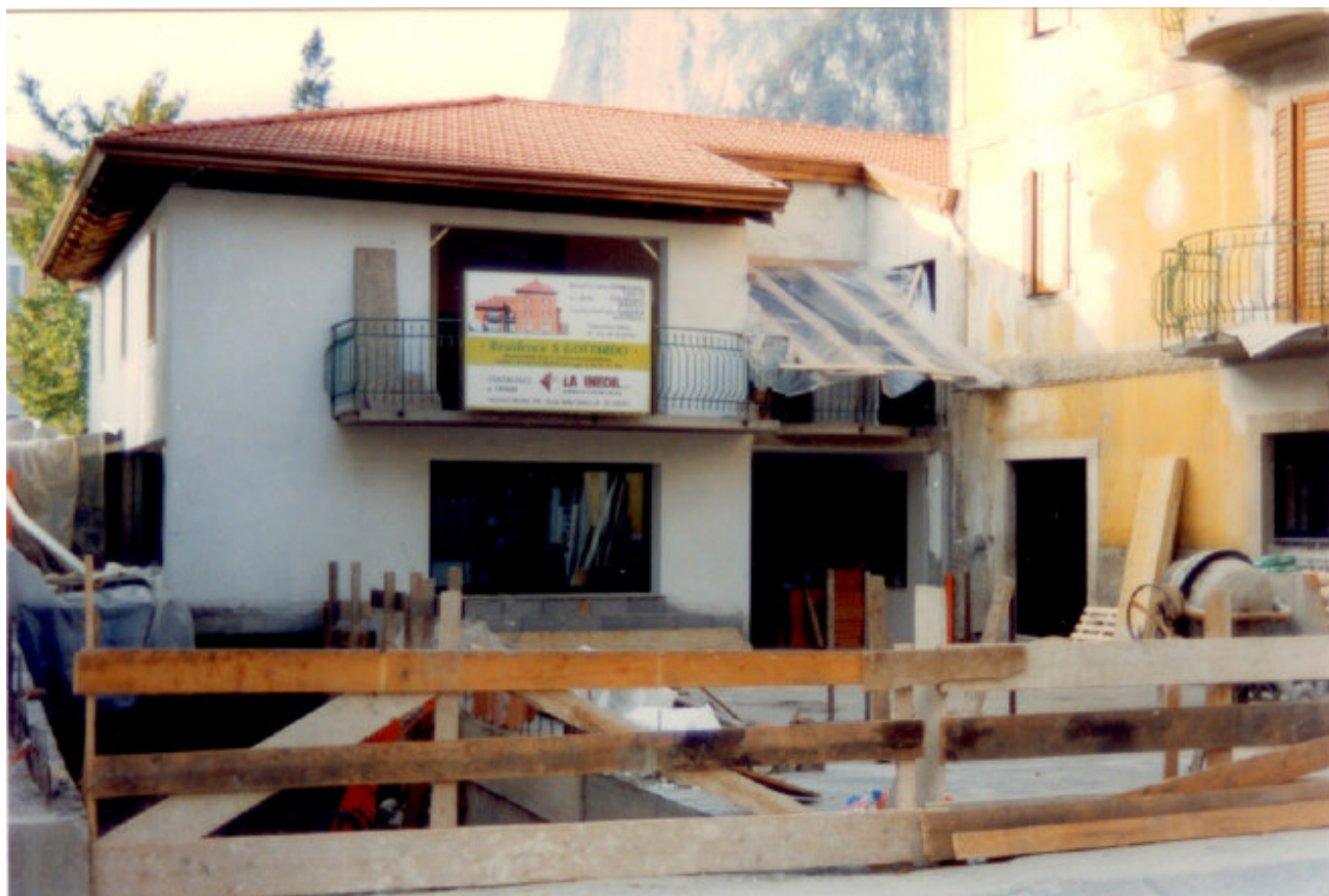
SCORCIO EST (durante i lavori di ristrutturazione)
