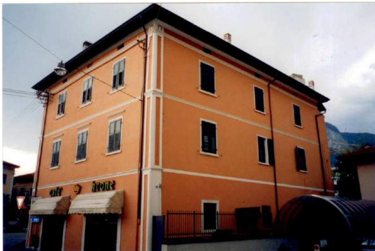
SCORCIO NORD EST (dopo la ristrutturazione)
