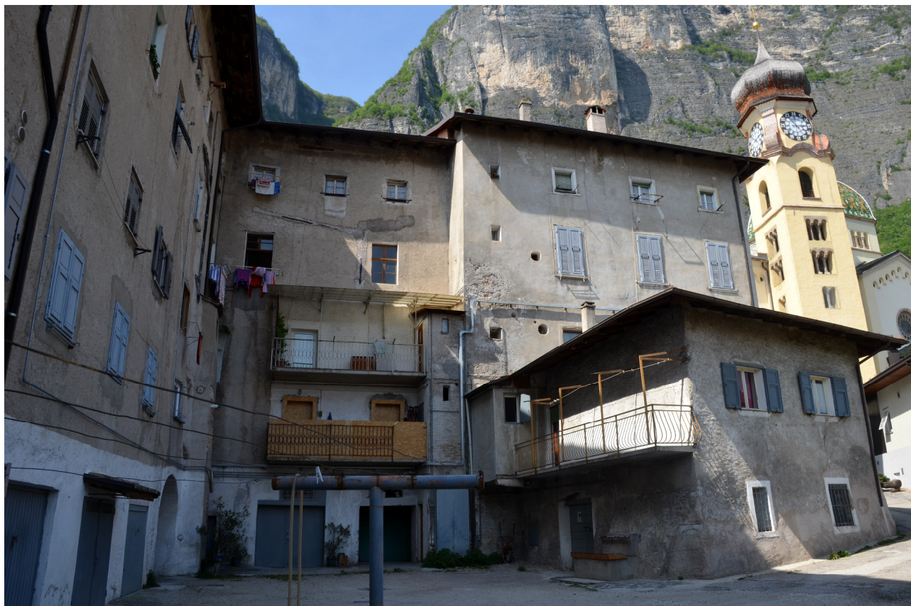
SCORCIO SUD OVEST (INTERNO CORTILE)
