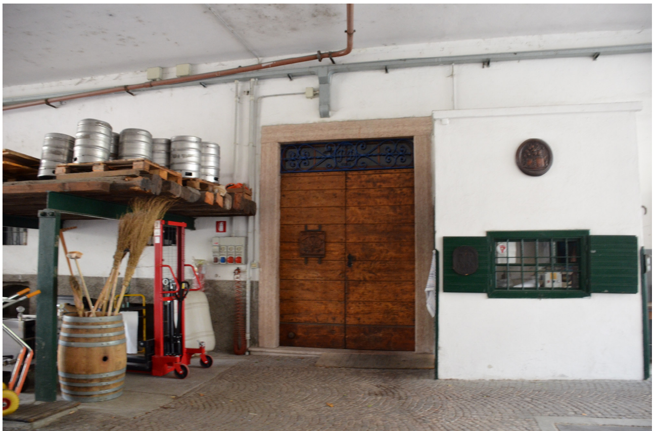
SCORCIO NORD IN CORRISPONDENZA DELLA U.E. 194
