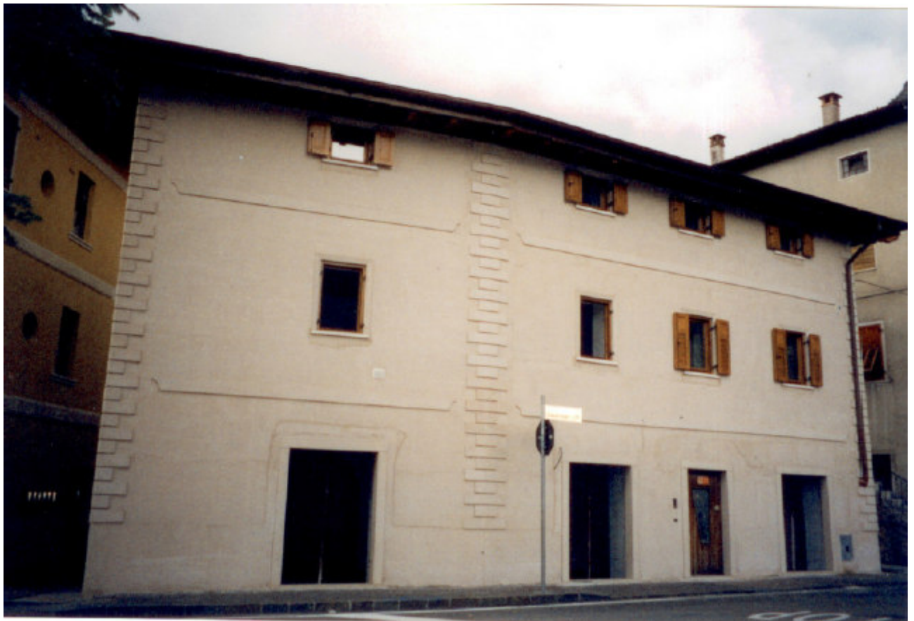
SCORCIO EST (dopo la ristrutturazione)
