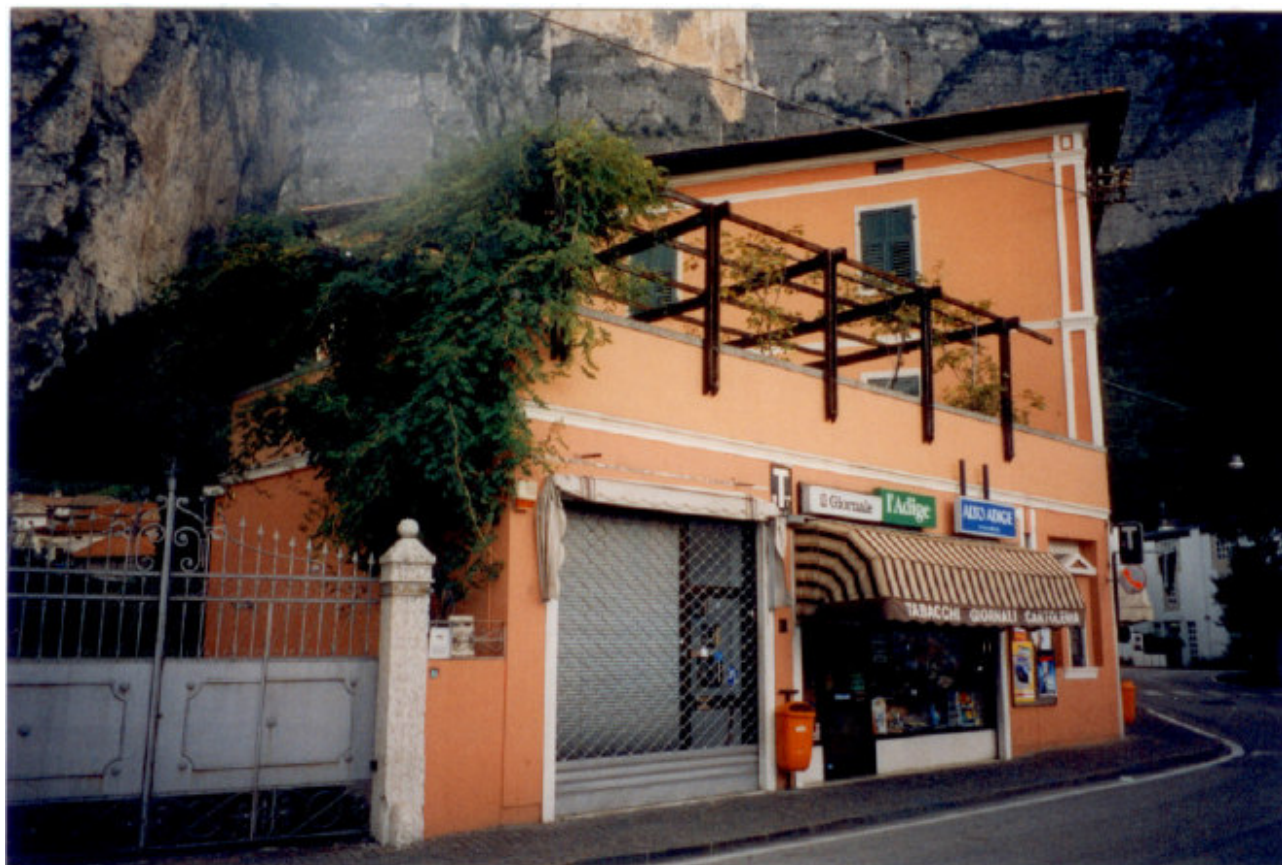
SCORCIO SUD OVEST (dopo la ristrutturazione)
