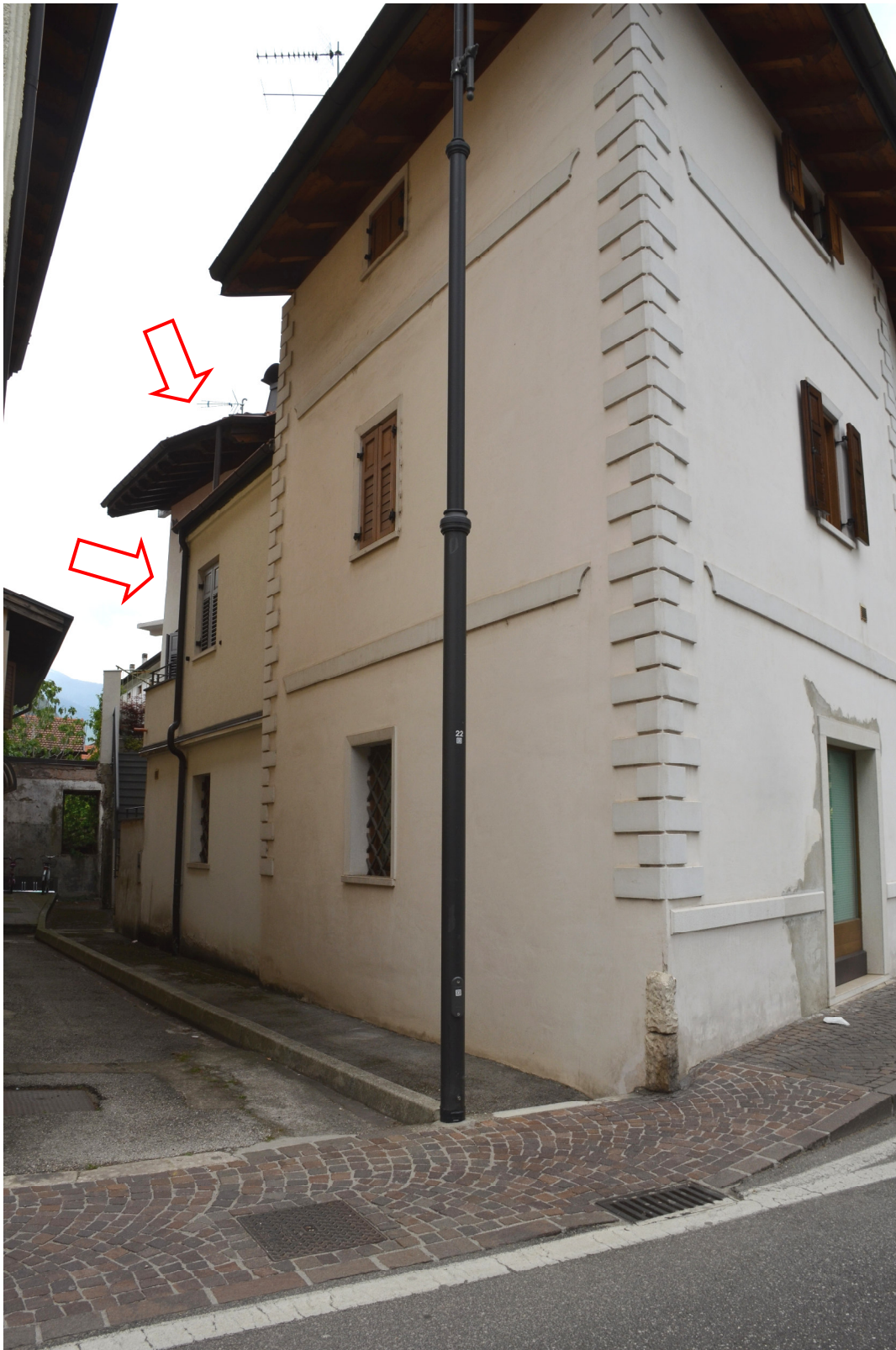
SCORCIO SUD U.E. 187 e 189
