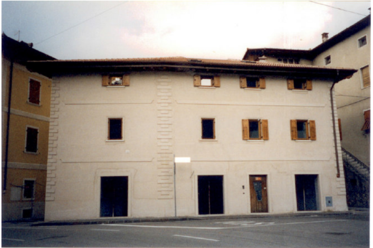
SCORCIO EST (dopo la ristrutturazione e la demolizione della U.E. 188)
