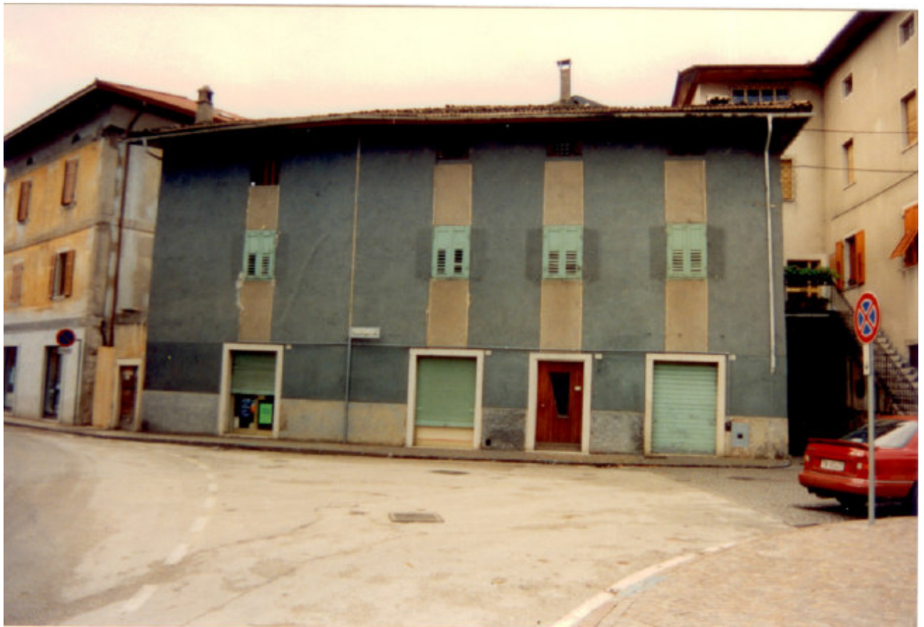
SCORCIO EST (prima della ristrutturazione)
