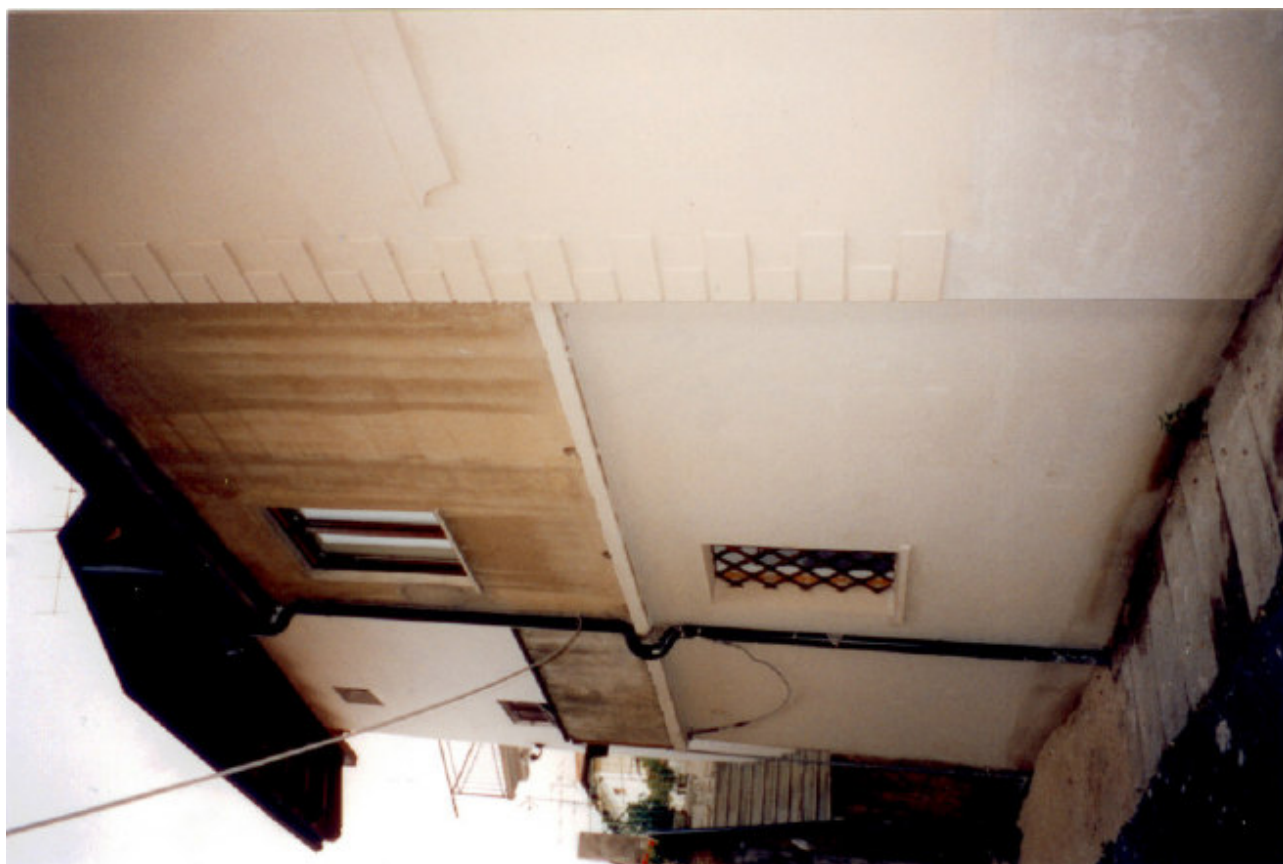
SCORCIO NORD (dopo la ristrutturazione)
