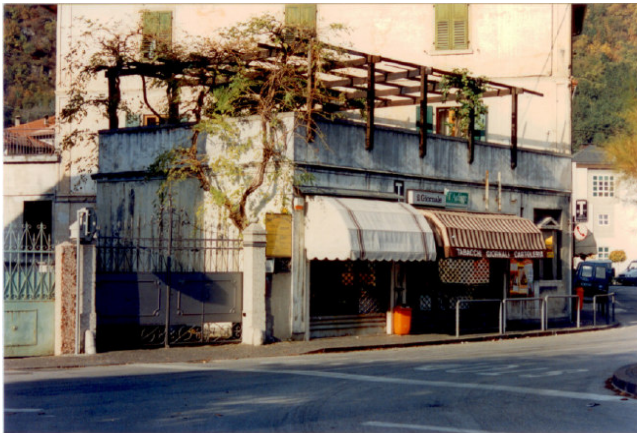
SCORCIO SUD OVEST (prima della ristrutturazione)
