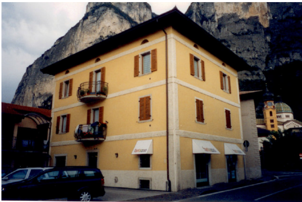
SCORCIO SUD EST (dopo i lavori di ristrutturazione)
