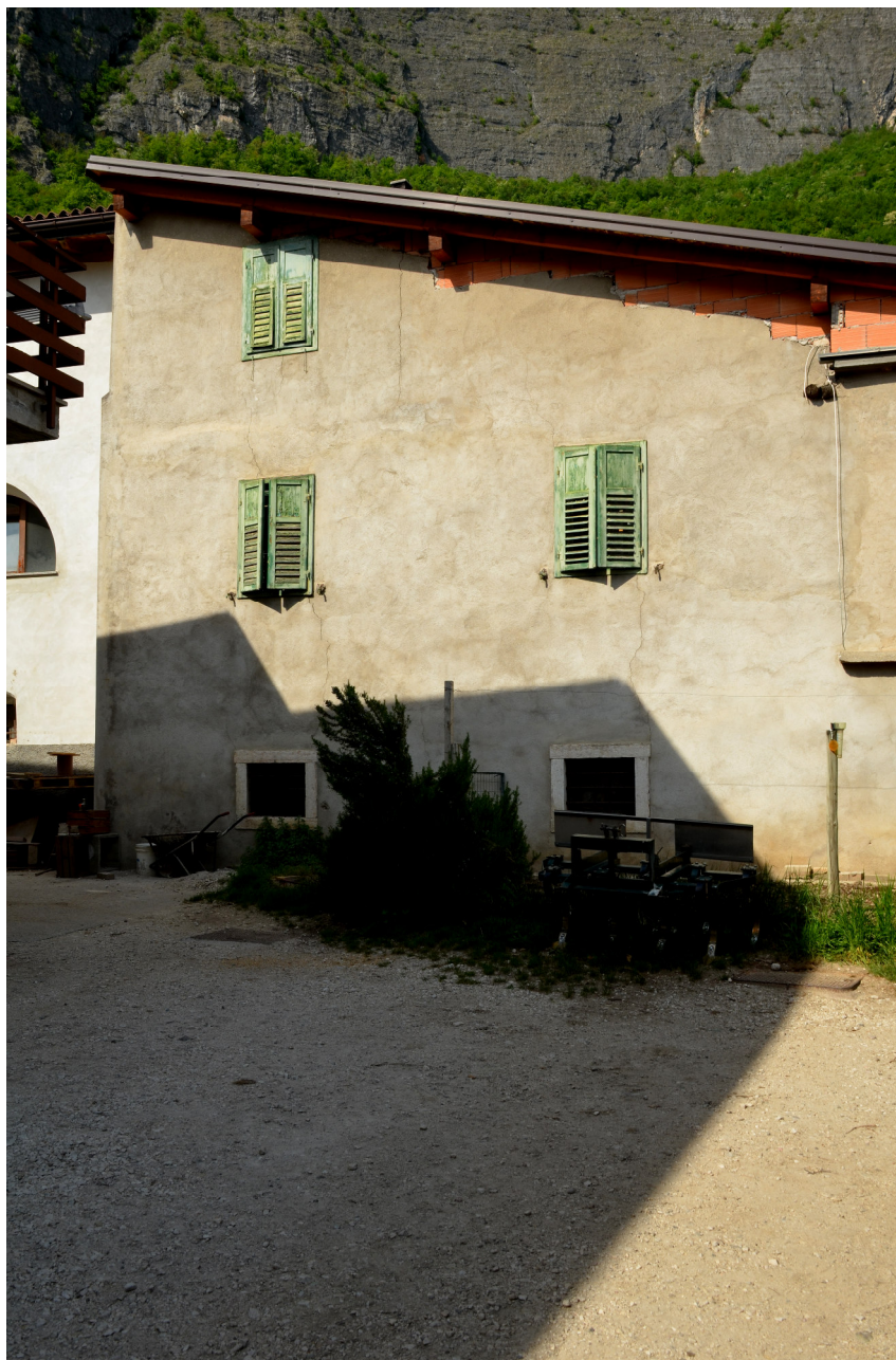
SCORCIO LATO SUD
