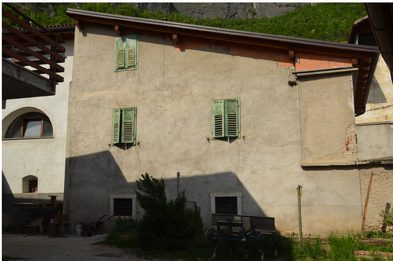
SCORCIO LATO SUD
