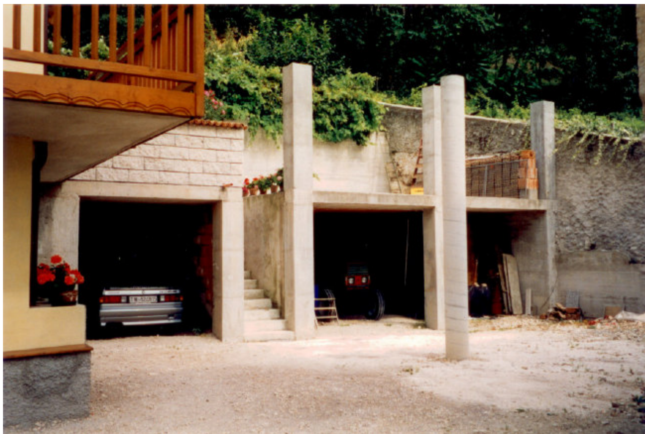
ANGOLO SUD OVEST (ristrutturazione in corso)
