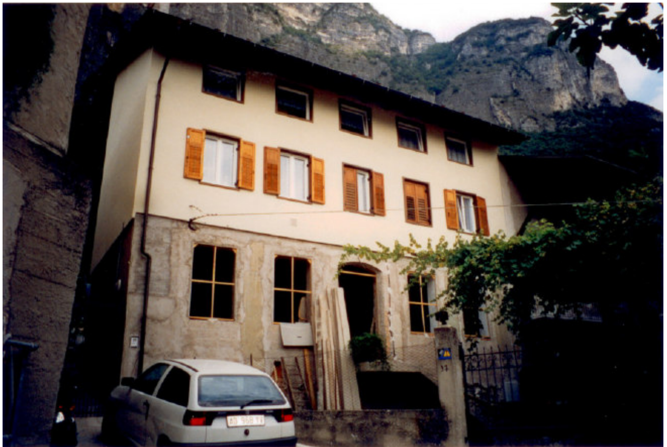
SCORCIO SUD (ristrutturazione in corso)
