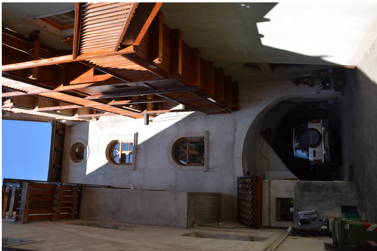
SCORCIO EST (interno corte)
