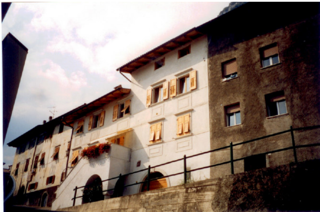
FRONTE SUD (dopo la sistemazione)
