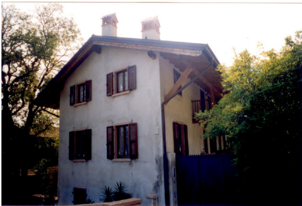
ANGOLO NORD EST (dopo la sistemazione)
