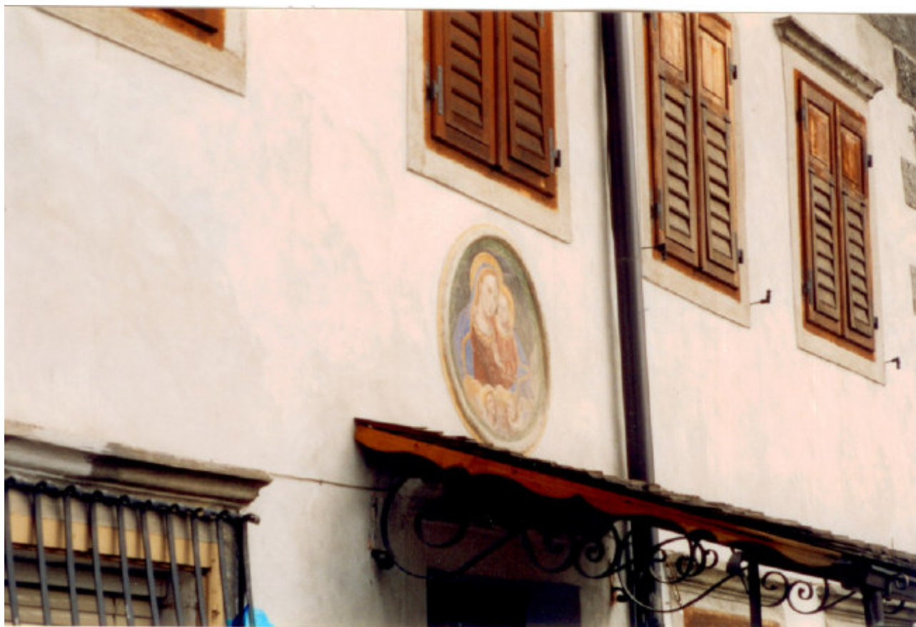
PARTICOLARE SUL FRONTE SUD
