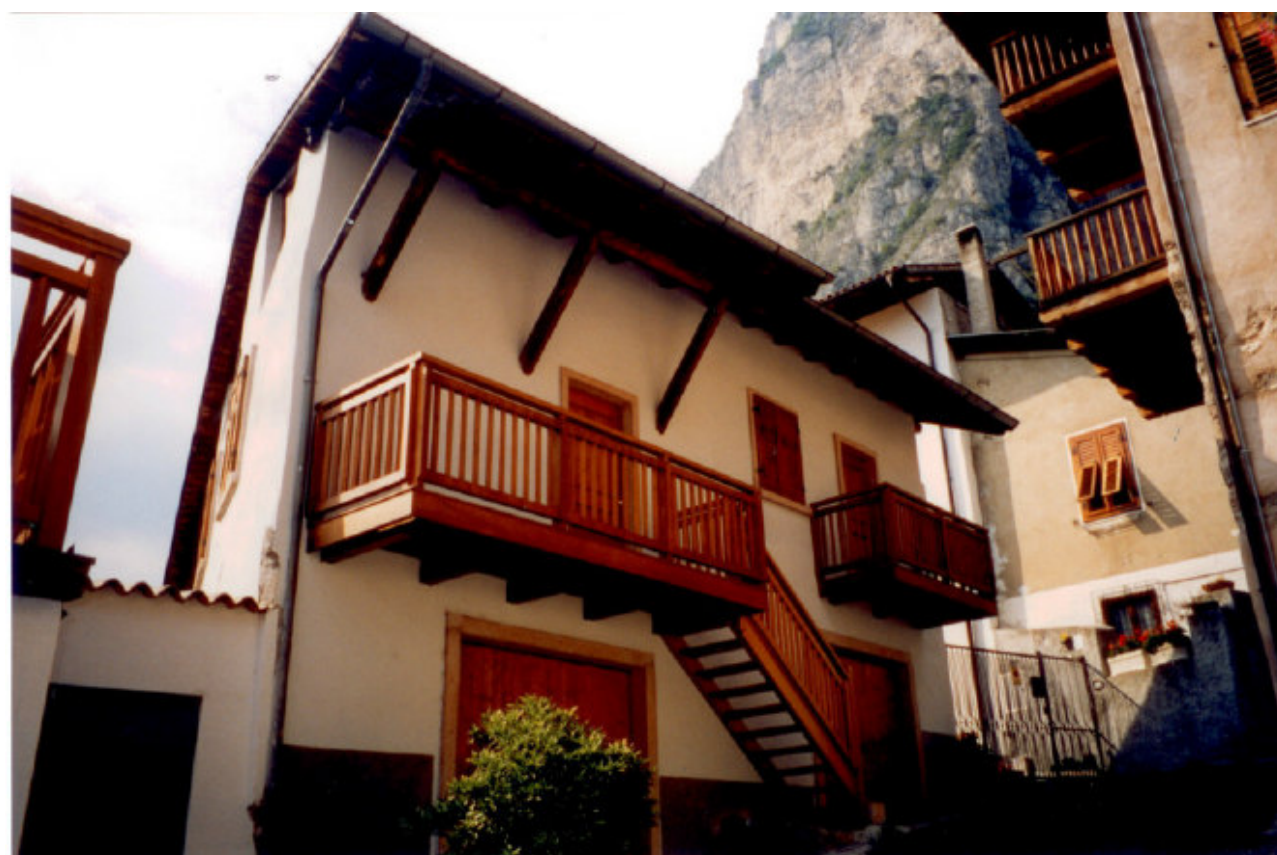
SCORCIO EST (dopo la sistemazione)
