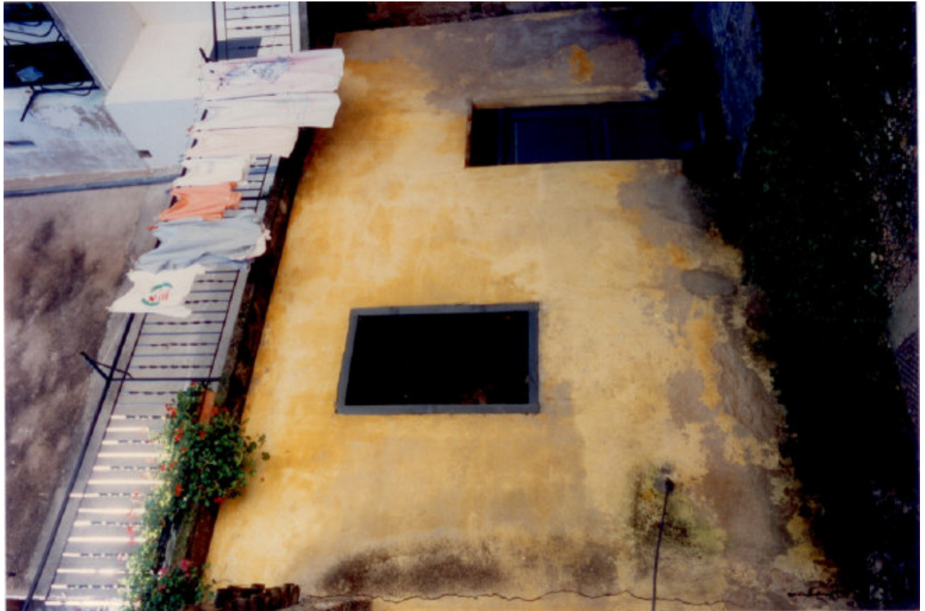
SCORCIO INTERNO LATO EST
