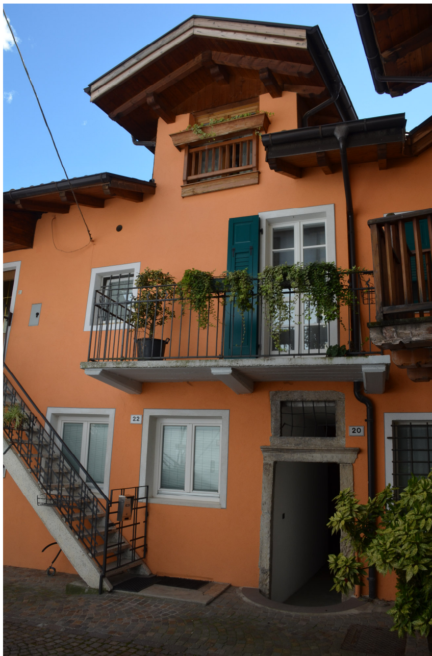
SCORCIO NORD (porzione ristrutturata)
