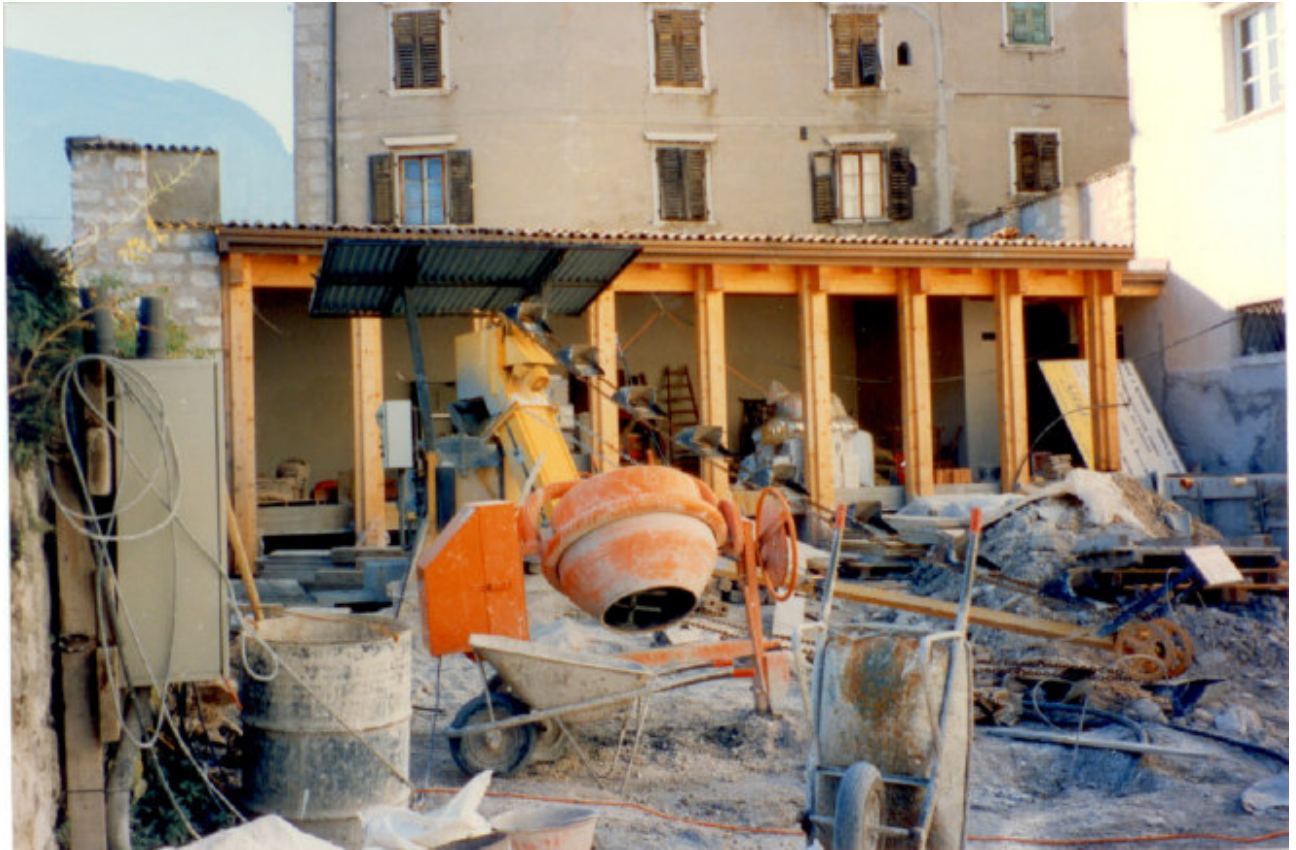
SCORCIO EST (prima della ristrutturazione)
