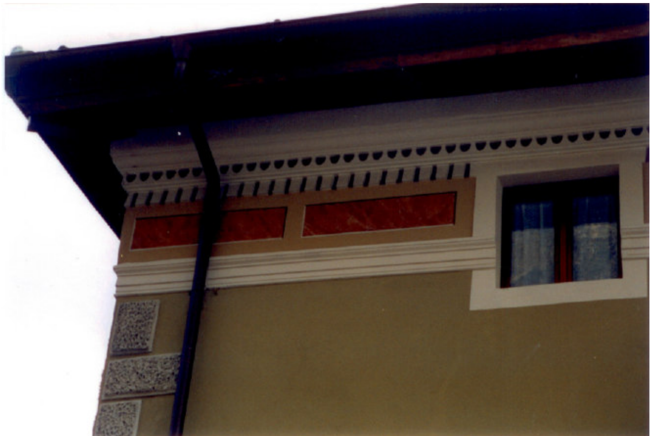
SCORCIO NORD PARTICOLARE
