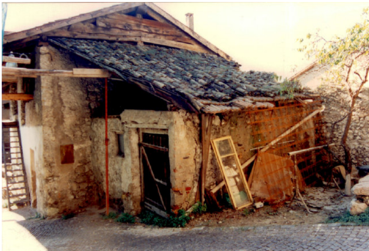
SCORCIO NORD (prima del risanamento)
