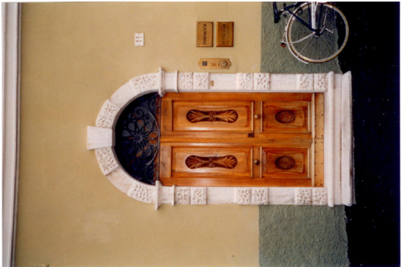
SCORCIO NORD PARTICOLARE
