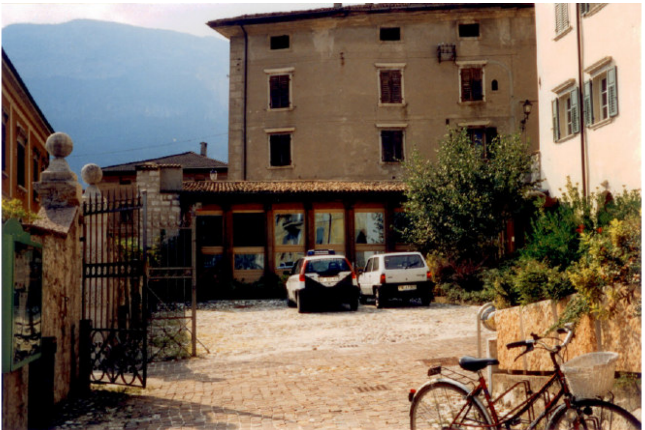
SCORCIO EST (dopo la ristrutturazione)
