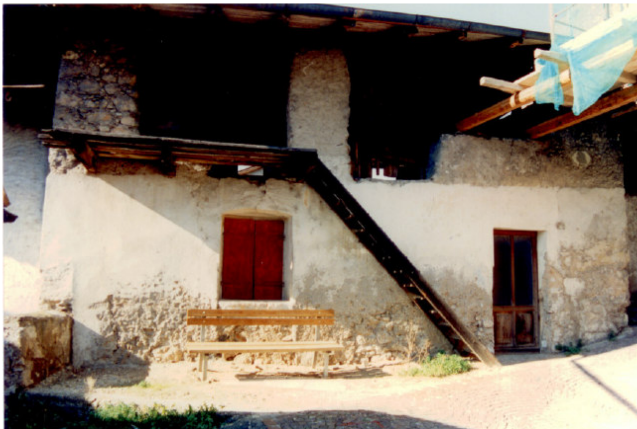
SCORCIO SUD (prima del risanamento)
