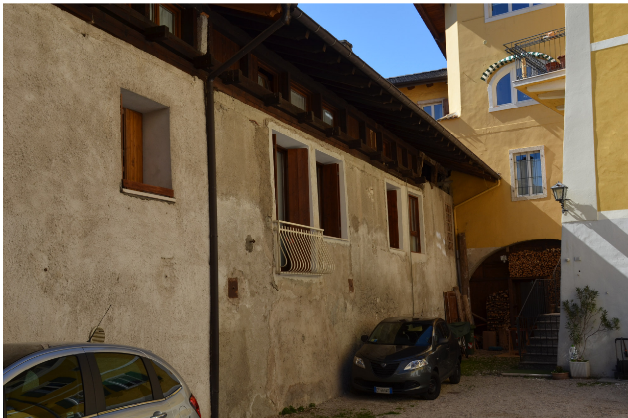
SCORCIO NORD (CORTE INTERNA)
