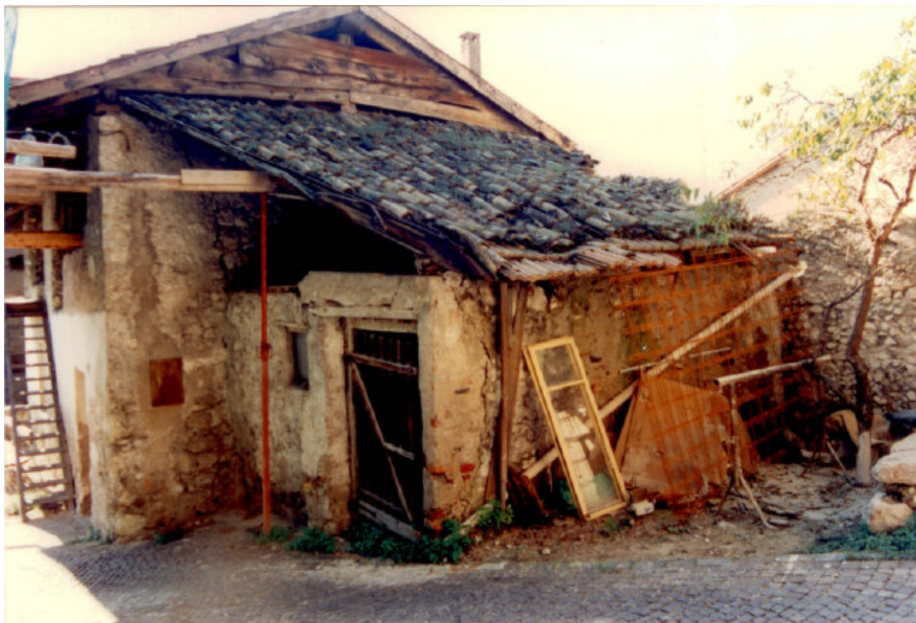
SCORCIO NORD (prima del risanamento)
