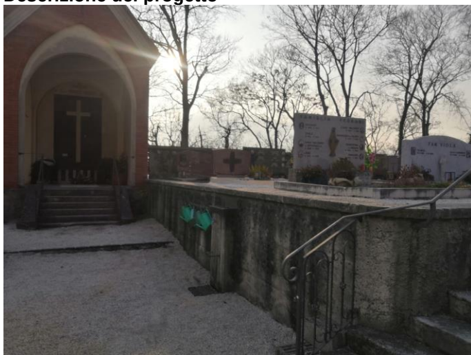
muro cimitero vecchio
